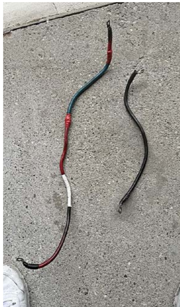
Kabel getauscht Cable replaced
